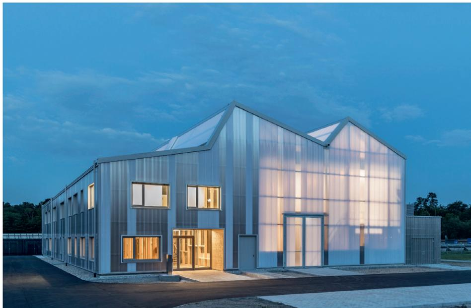
*Institut für Technologie (KIT) Energy Lab, Transluzente Fassade; Polycarbonat-Fassade*
