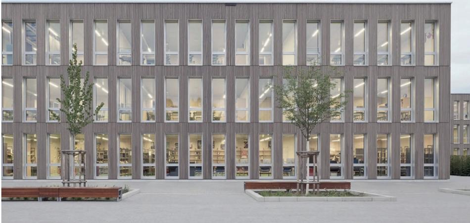
Modulbau, Gymnasium Frankfurt, Holzwerkstofffassade; vertikale Holzlamellen
