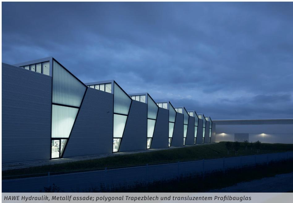
HAWE Hydraulik, Metallfassade; polygonal Trapezblech und transluzentem Profilbauglas
