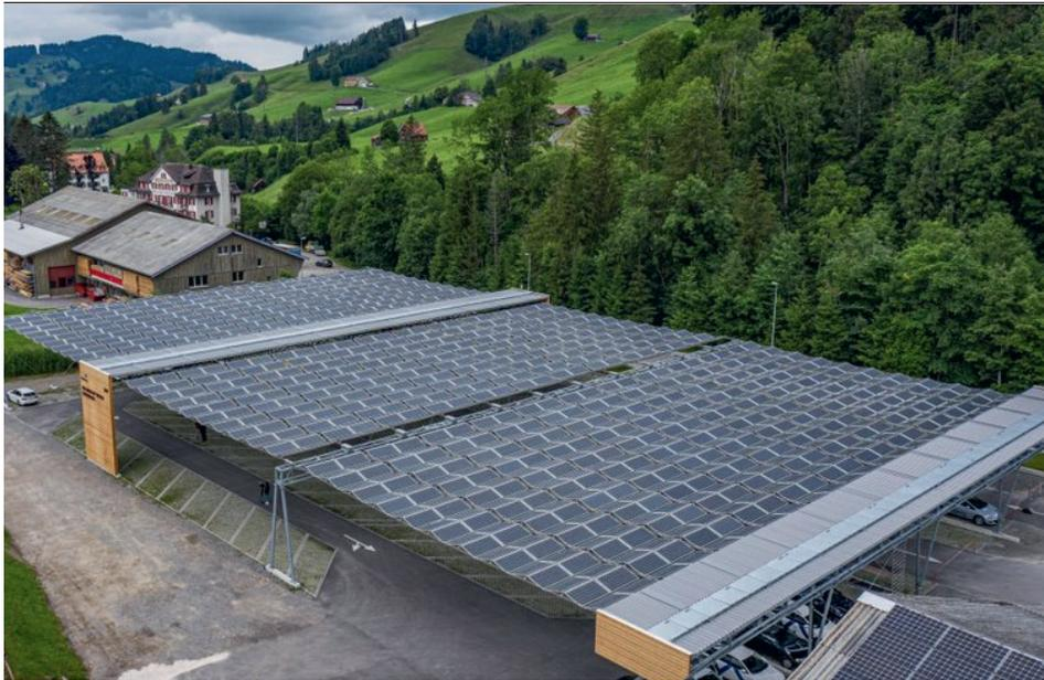
Beispiel für Solarfaltdach als innovativ und leicht wirkende Lösung für Stellplatzüberdachungen.
