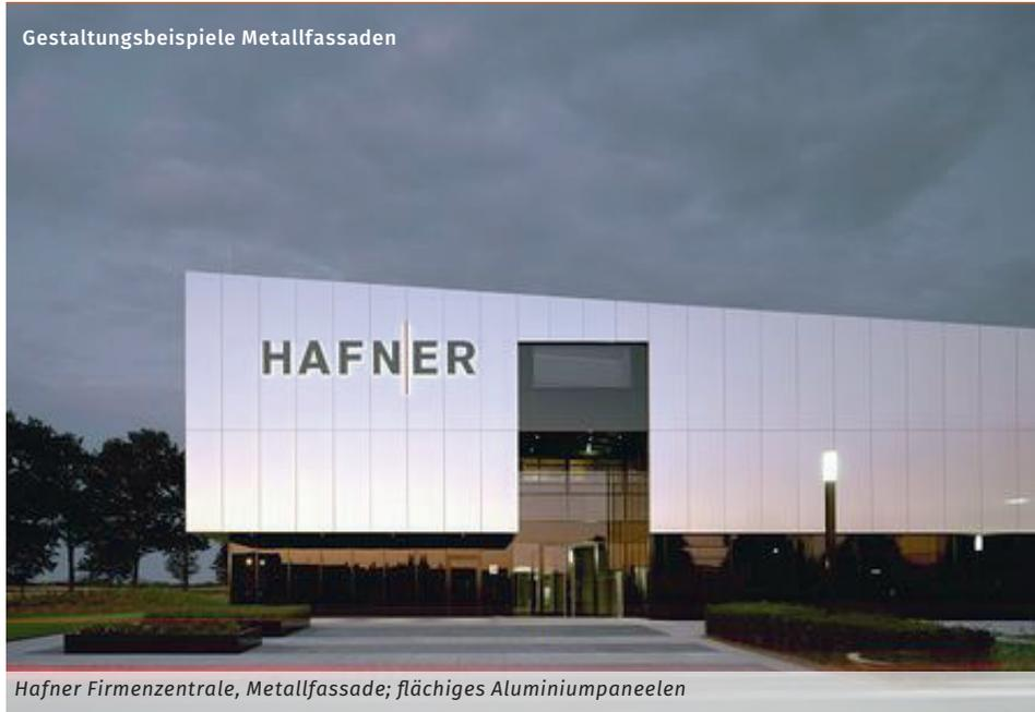
Hafner Firmenzentrale, Metallfassade; flächiges Aluminiumpaneelen
